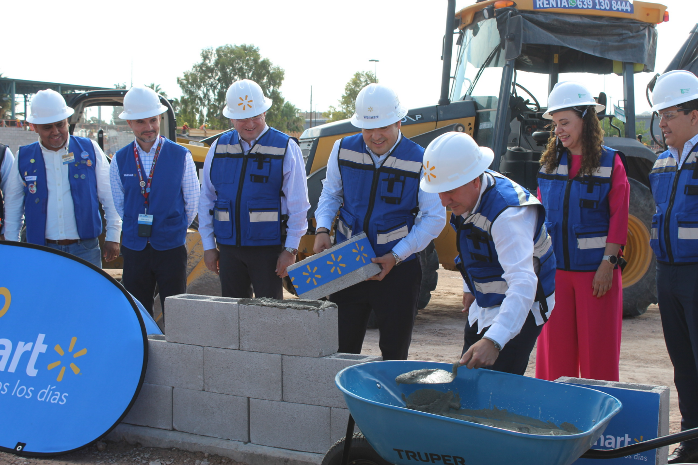
Primera piedra en la obra para la reconstrucción de Walmart.
